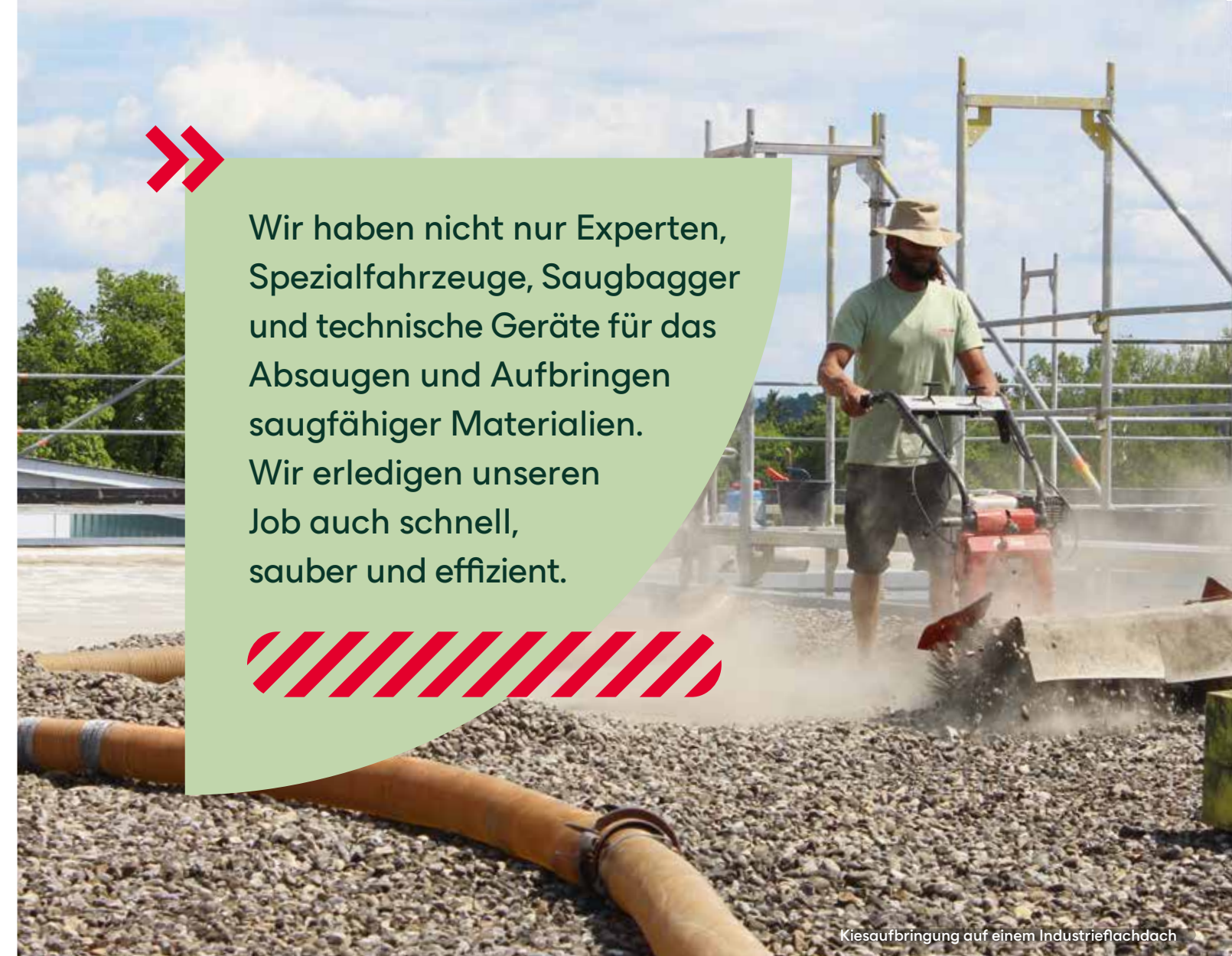
Entkiesung eines Daches
