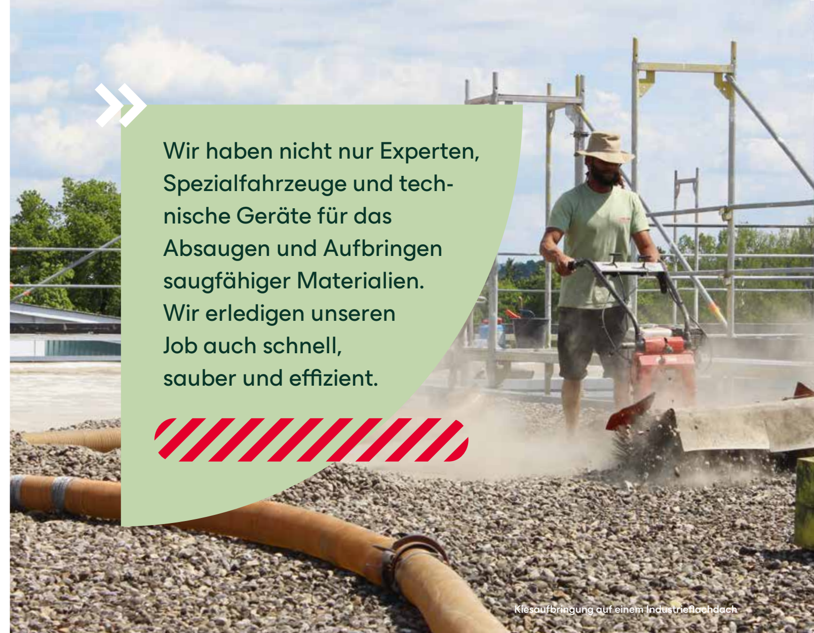
Bekiesung eines Daches
