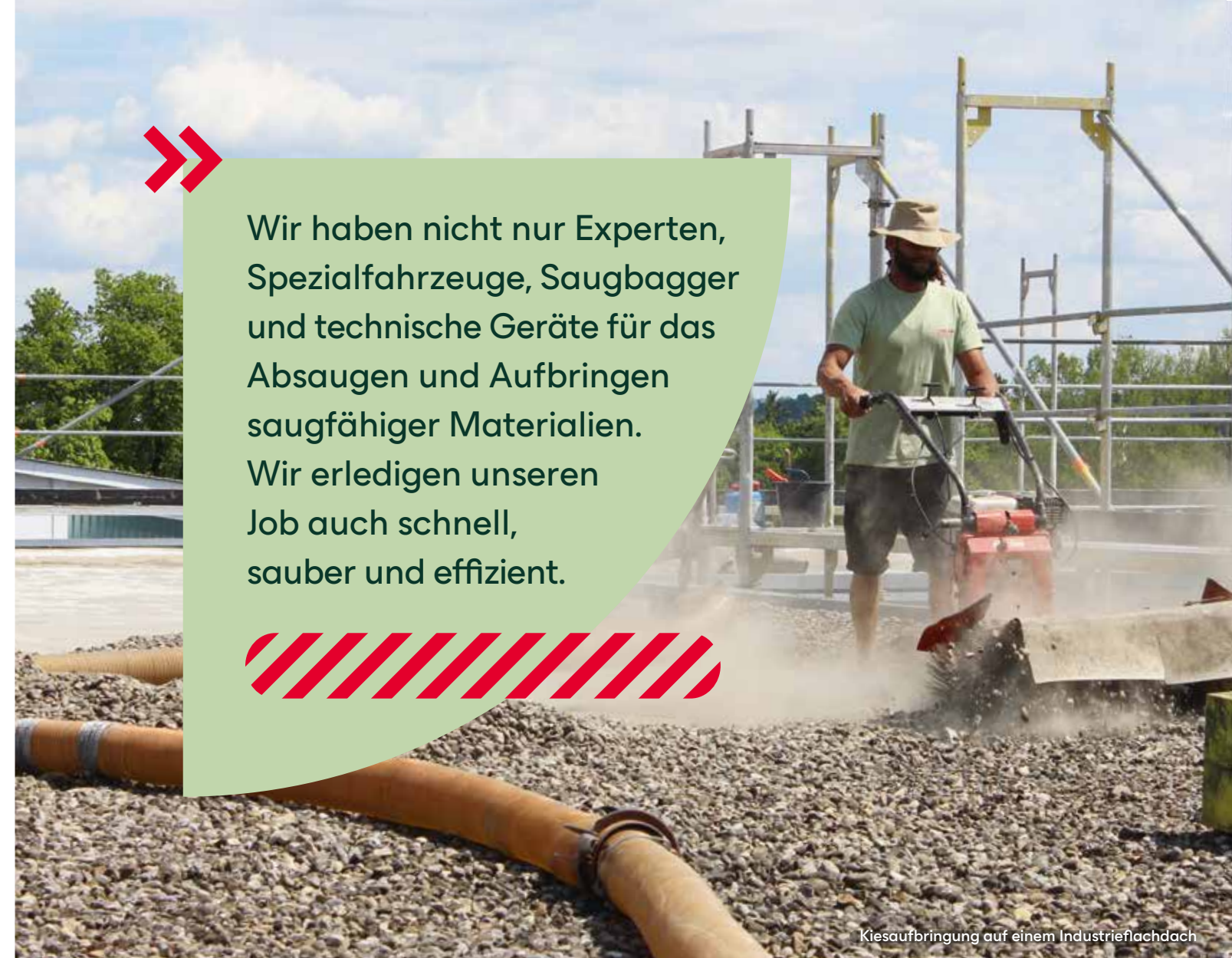
Entkiesung eines Daches
