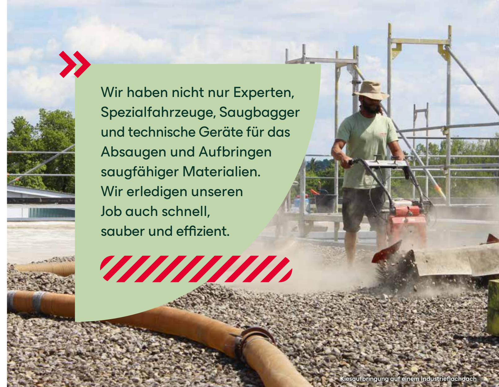
Entkiesung eines Daches
